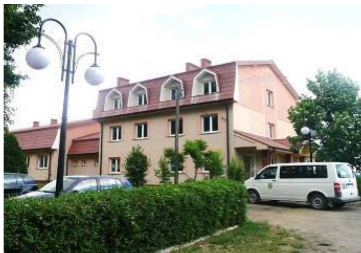
Budynek ŚDS w Miłaczewie
